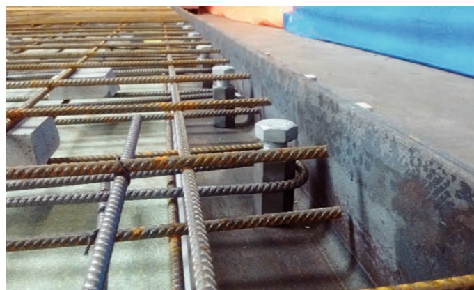
5a. Detail demontabele afschuifverbindingmiddelen in de prefab betonnen vloerelementen voorafgaand aan het storten.
