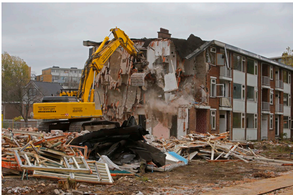
Figure 3. T. Stolk, Demolition flats Dordrecht , 2018, photo, 1120x747, DordtCentraal, https://dordtcentraal.nl/actueel/video-gejuich-om-sloop-portiekflats/ .
