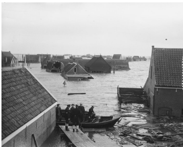
(a) Schouwen Duiveland. Nieuwerkerk
