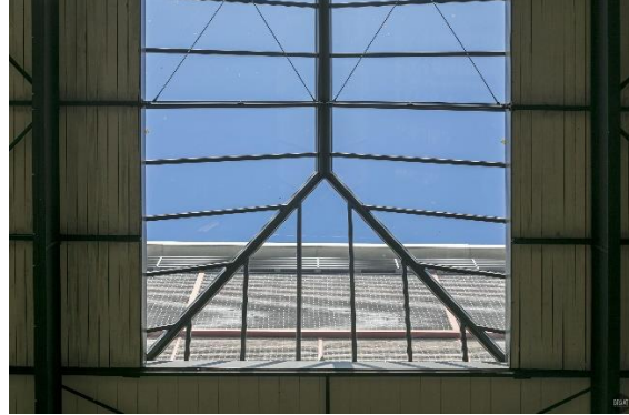
Figure 22: Detailed photo of steel skylight (Luuk Kramer, n.d.)
