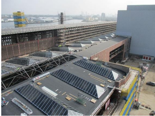
Figure 21: Installing 27 skylights on the Ketelmakerij and Grofsmederij (Luuk Kramer, n.d.)
