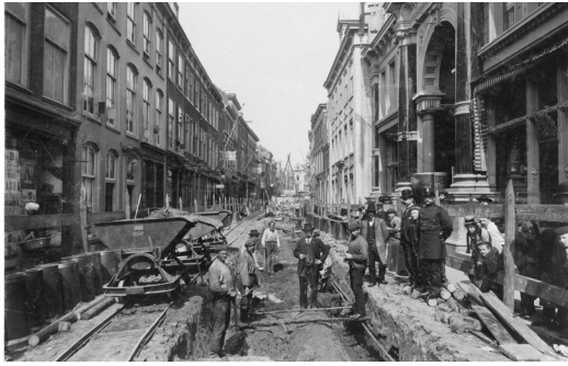
◀ Figure 3.24. Wagenstraat, aanleg riolering (ca. 1910)
