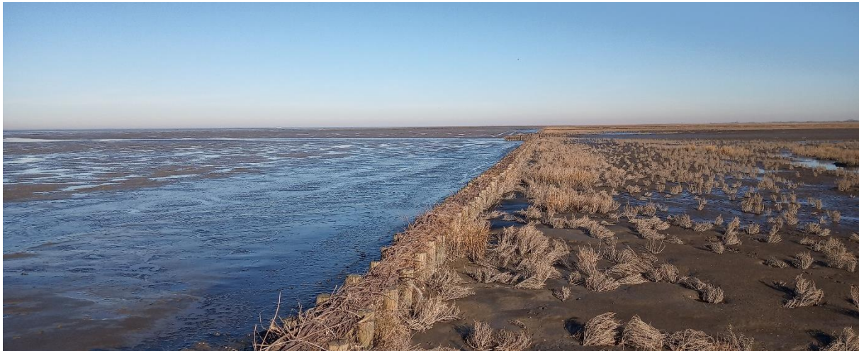
Figuur 4 Rijshoutdam op het voorland Noarderleech (foto 15 feb. '19)
