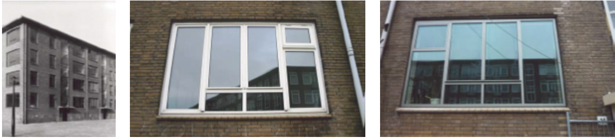
Fig 13. Change of window frames at the project 'Koningsvrouwen van Landlust'
